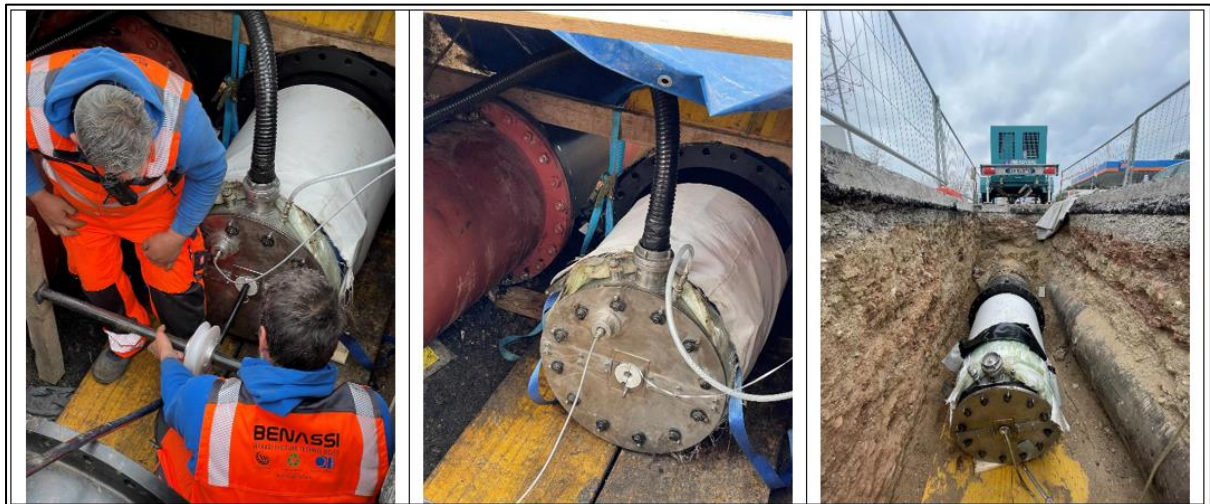
Foto 15 – Montaggio dei packer (sinistra), situazione lato inserimento (centro), e lato tiro (destra)
