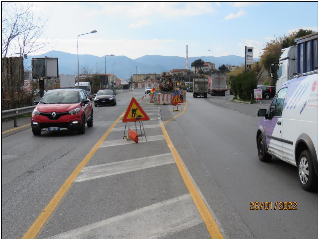
Foto 26 – Particolari: cantierizzazione su Corso Svizzera minimale, con disagi minimi alla circolazione dei mezzi, anche pesanti
