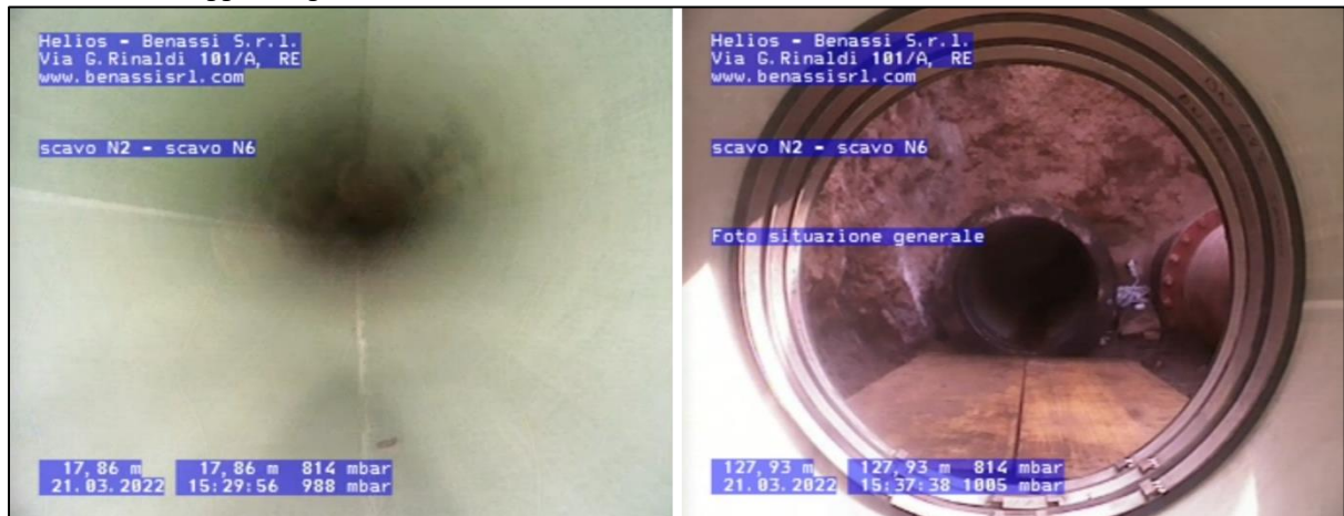
Foto 19 – Videoispezione finale (condotta monte 21/02/2022 – condotta mare 21/03/2022)
