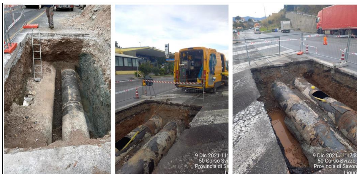
Foto 8 – Scavo e messa a nudo delle tubazioni per esecuzione videoispezione preliminare
