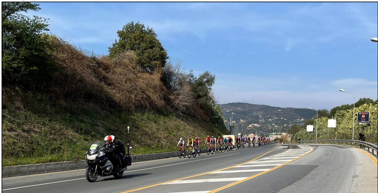
Foto 27 – Particolari: è stato possibile il transito della manifestazione ciclistica “Milano-San Remo” con impatti minimi sull’organizzazione della viabilità conseguente al cantiere (in foto il tratto dal pozzetto AB)
