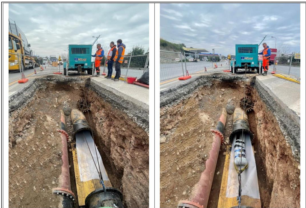
Foto 13 – Inserimento Liner – Situazione lato scavo trainoD
