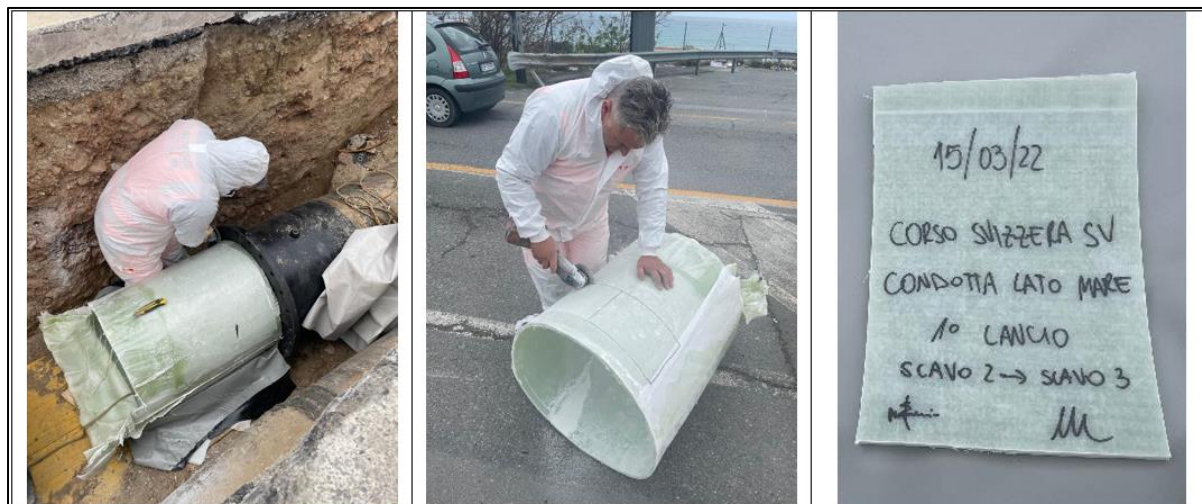
Foto 17 – Taglio della porzione terminale del liner e prelievo campioni per prove di laboratorio
