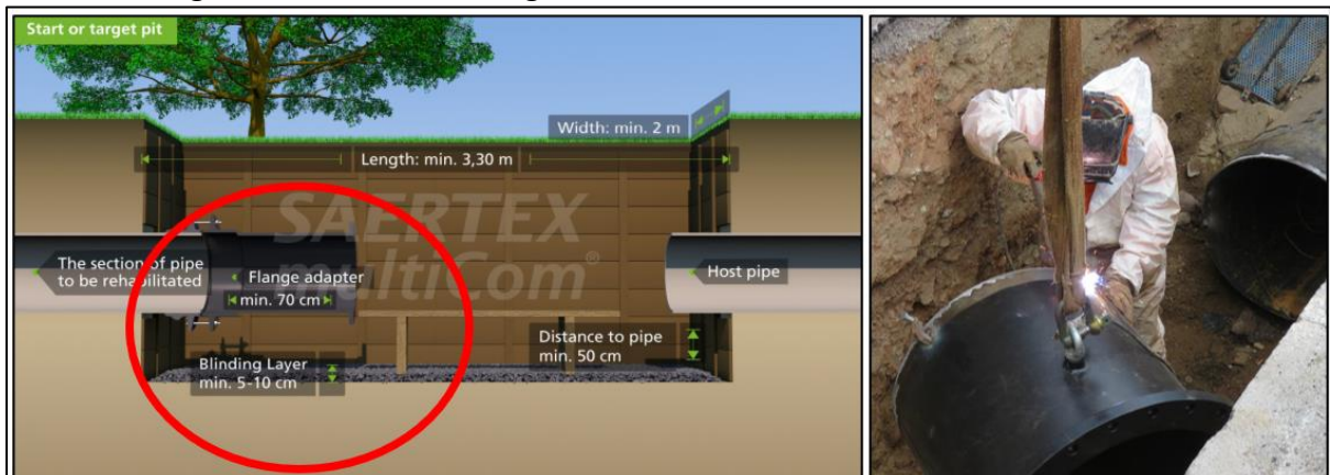
Foto 10 – Saldatura tronchetto in acciaio all’estremità del tratto da risanare
